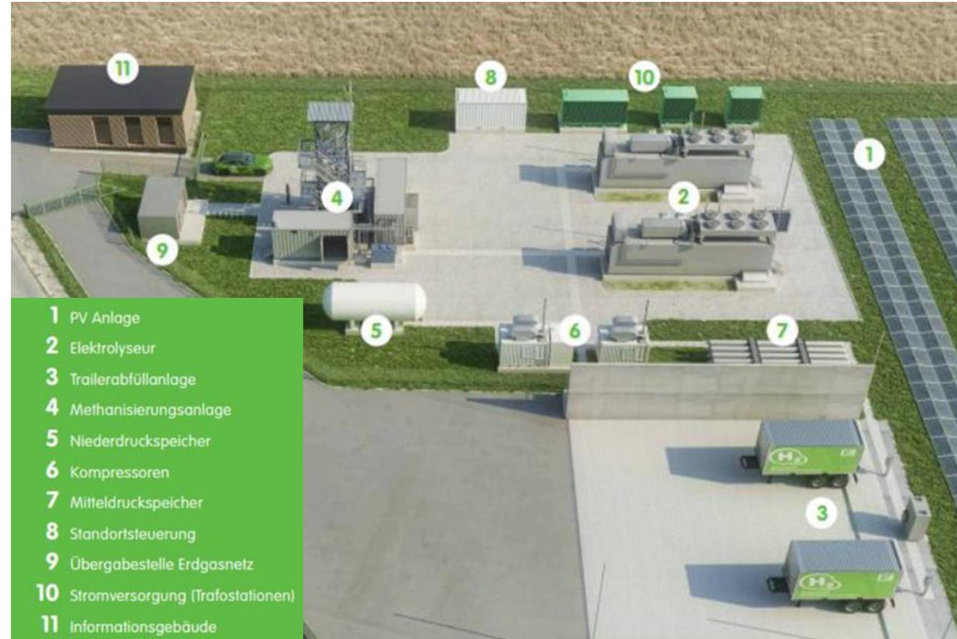
\*2. Elektrolyseur in 1. Ausbaustufe nicht ausgeführt
