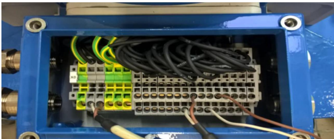
Abb. 8.19: Anschluss der RS 485-2 (22 +, 23 -) am USM GT400
