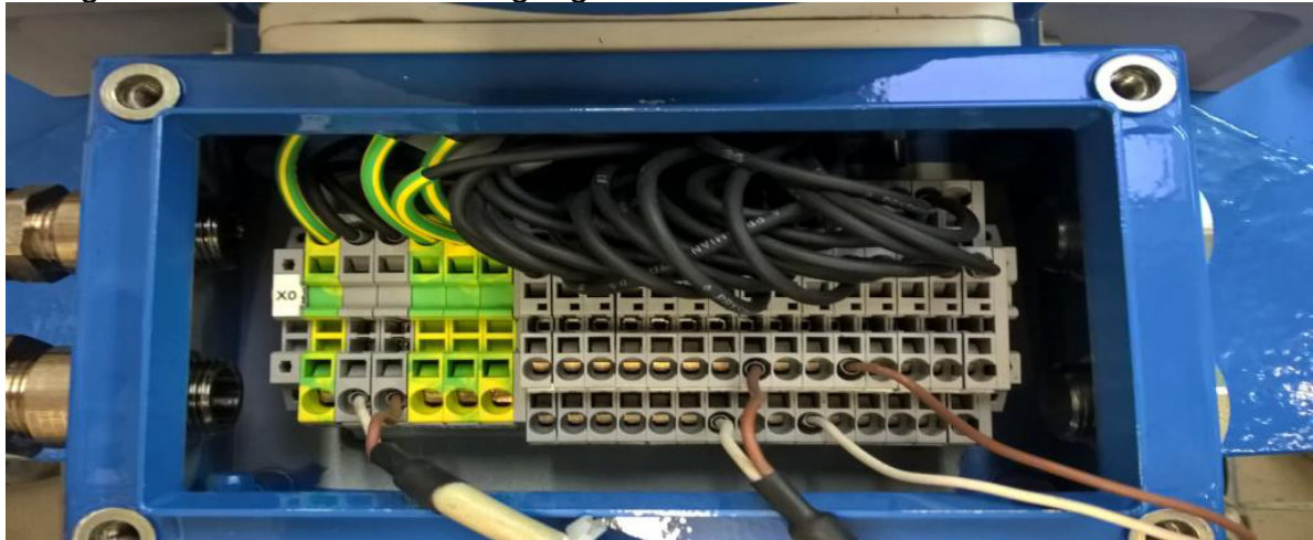
Abbildung 165: Anschluss der RS 485-2 (22 +, 23 -) am USM GT400
