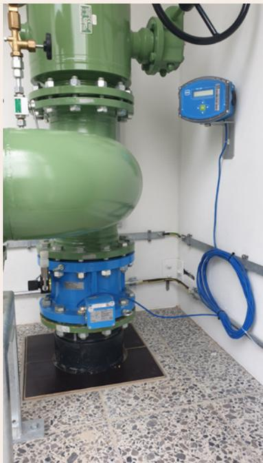
**Bild 4:** Installationsbeispiel: Elektronischer Turbinenradzähler mit abgesetztem Zählwerk
